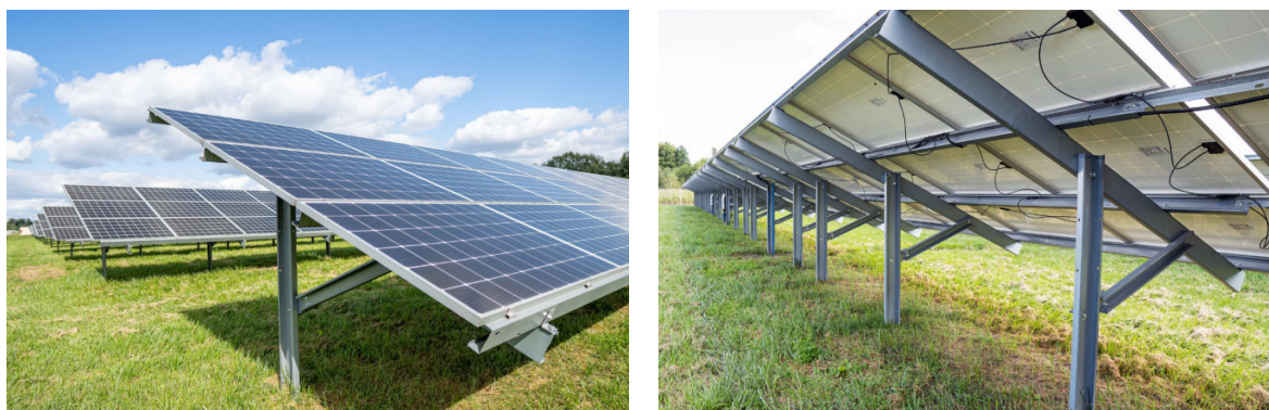
Rys. 3.5. Przedstawienie przykładowych konstrukcji pod panele fotowoltaiczne
