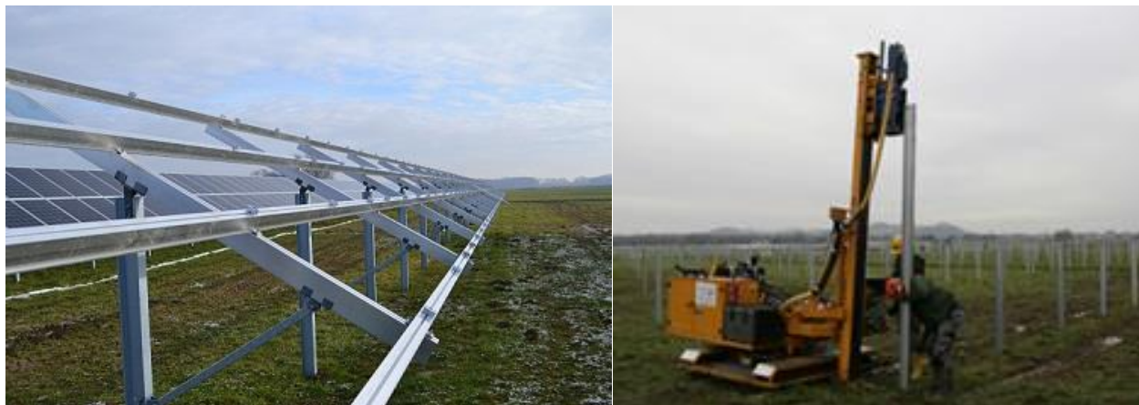
Rysunek nr 4 Przedstawia sposób montażu konstrukcji, na których montowane są panele PV. Źródło: gramwzielone.pl
